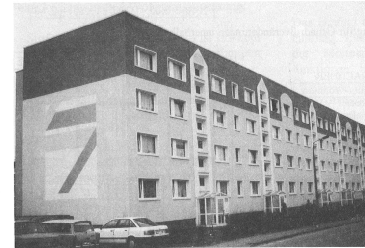
Bild 7.1: Neugestaltung eines modernisierten Wohngebäudes in der Blockbauart 0,8 t, Standort Zehdenick
